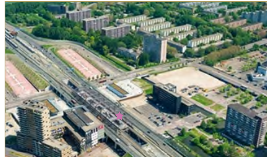
Luchtfoto: Centrumgebied Amsterdam-Noord.
